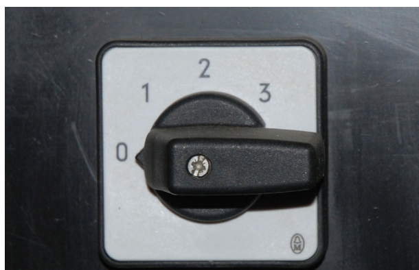
Interrupteur à 4 positions qui commute chaque moteur individuellement.
